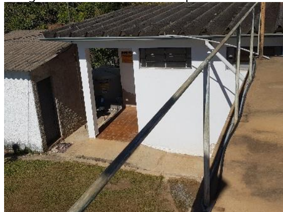
Figura 92. Vista da casa de química da ETA.
