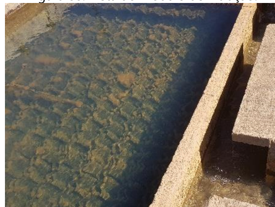
Figura 88. Vista do Módulo de filtração.
