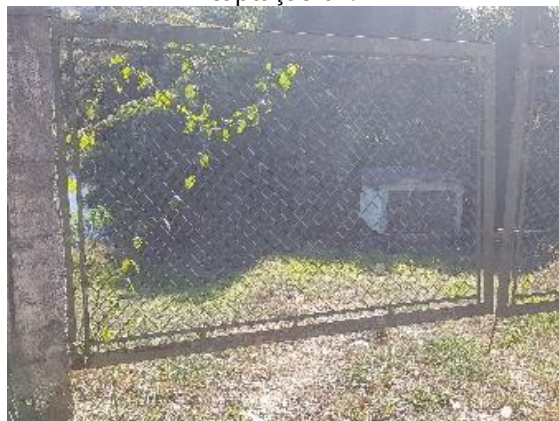
Figura 18. Vista Geral da entrada para a captação 02.
