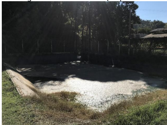
Figura 124. Vista do tanque pulmão.
