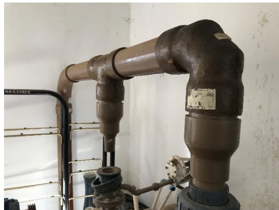
Figura 149. Vista do barrilete de recalque em PVC com acessórios em Fibra de Vidro.
