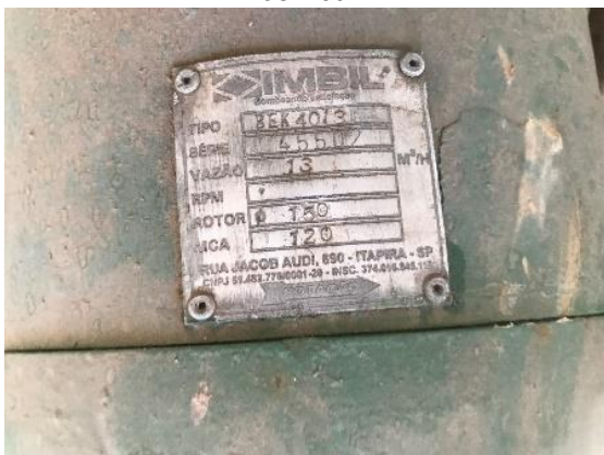
Figura 108. Vista da placa de identificação da bomba
