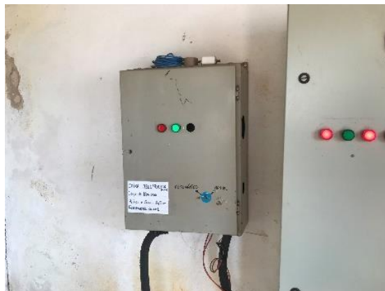
Figura 107. Vista do painel de controle das bombas da EEAT 01.
