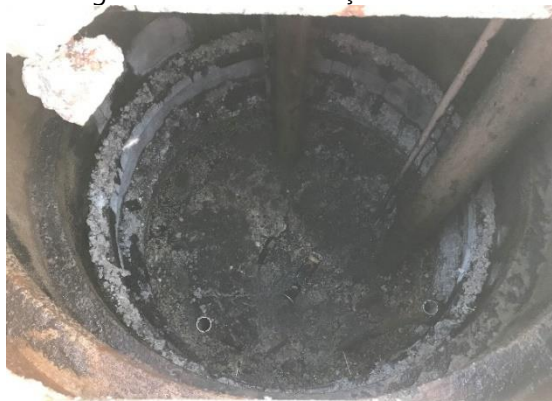
Figura 121. Vista do Poço da EEE 04.
