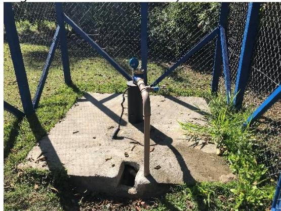
Figura 30. Vista Geral do Poço 02 – Prefeitura.
