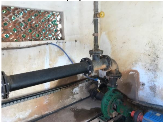
Figura 16. Vista Geral do barrilete de recalque da captação - 02.
