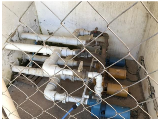
Figura 151. Vista do barrilete e dos conjuntos motor bombas.
