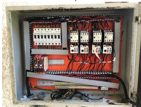
Figura 153. Vista interna do painel de comando e seus componentes.
