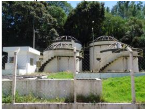
Figura 118. Vista geral da ETE.
