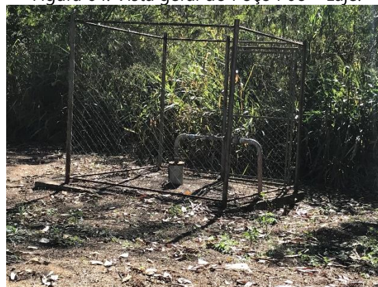
Figura 64. Vista geral do Poço P08 – Laje.
