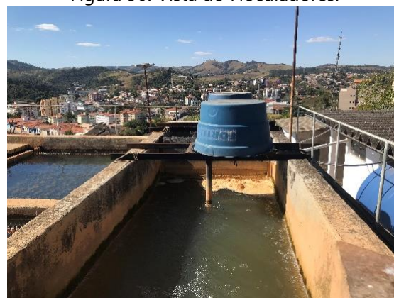
Figura 90. Vista do Floculadores.
