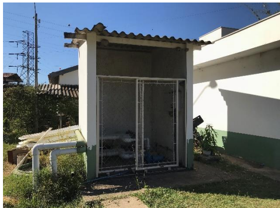
Figura 150. Vista geral do abrigo dos conjuntos motor bombas.
