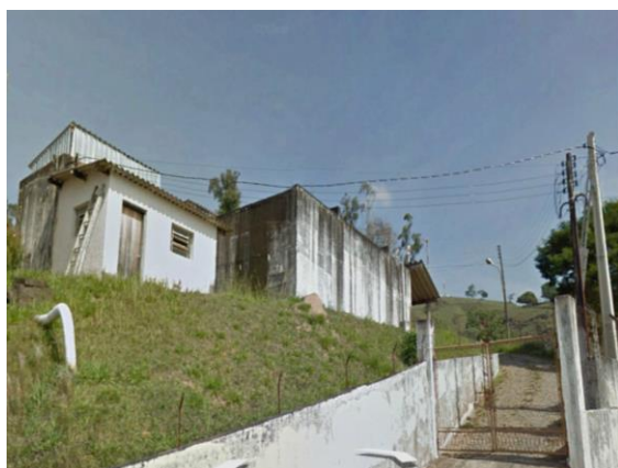
Figura 83. Vista da entrada da ETA.
