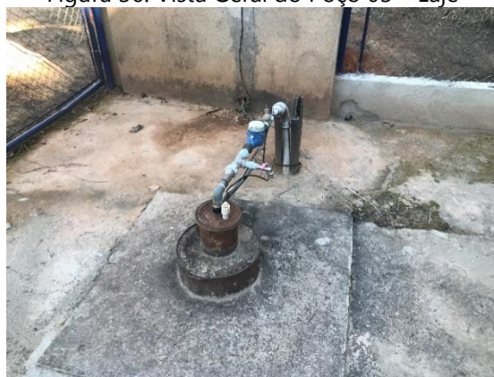
Figura 36. Vista Geral do Poço 03 – Laje
