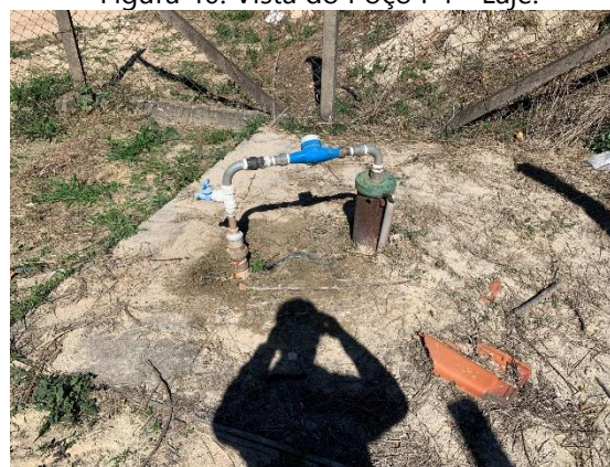
Figura 40. Vista do Poço P4 - Laje.
