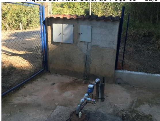
Figura 35. Vista Geral do Poço 03 – Laje
