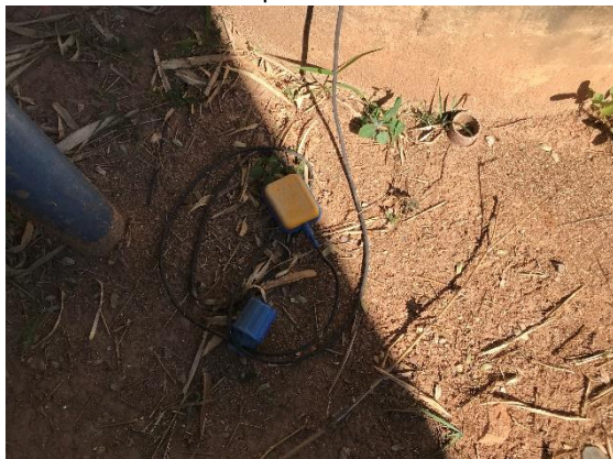
Figura 140. Vista do dispositivo de acionamento dos motores do tipo chave de boia elétrica.
