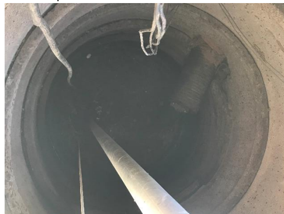
Figura 141. Vista do poço de sucção e do ponto de entrada do efluente.
