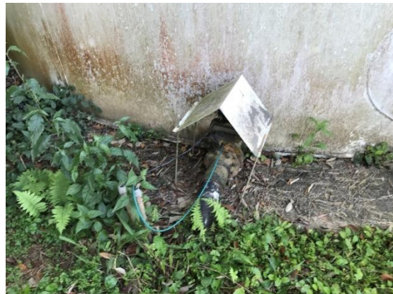
Figura 131. Vista das válvulas borboleta com atuador eletromecânico.
