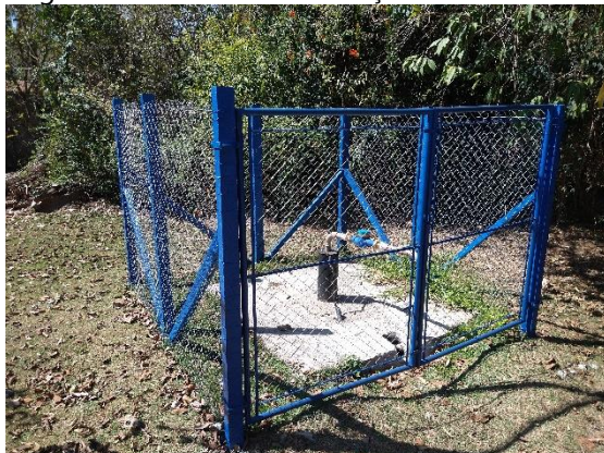
Figura 29. Vista Geral do Poço 02 – Prefeitura.
