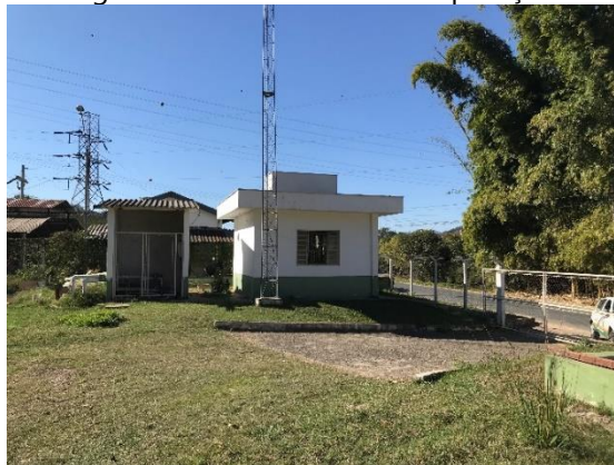
Figura 119. Vista da sala de operação.
