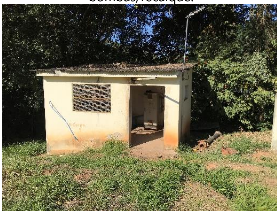
Figura 14. Vista Geral da casa de bombas/recalque.
